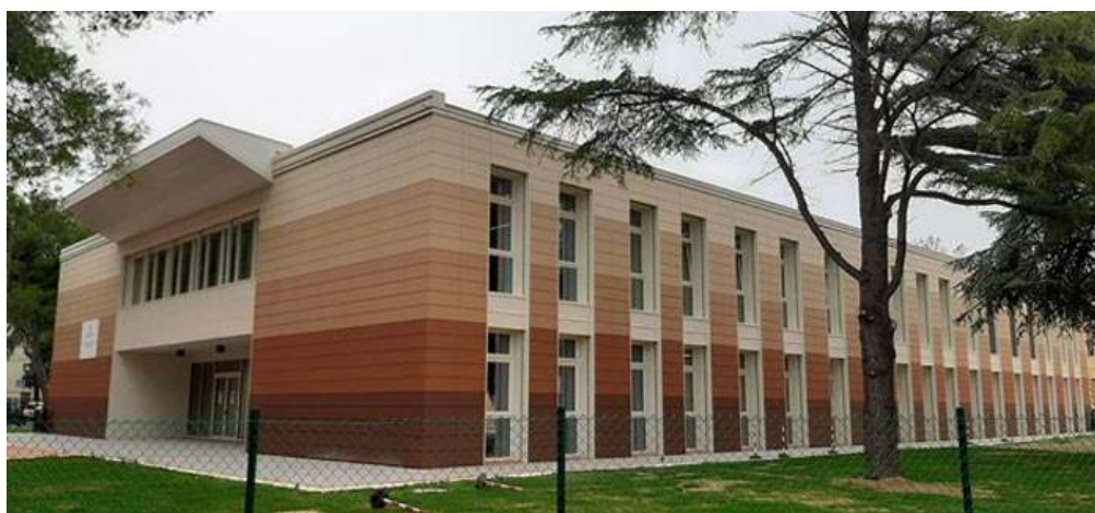
Rivestimento della facciata ventilata in gres porcellanato a manutenzione zero fonte Arch. M. Finamore
