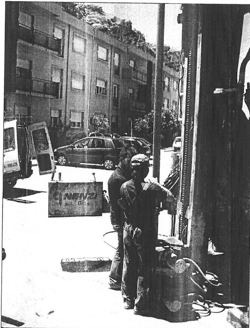
S1 - Installazione piezometri a tubo aperto per
