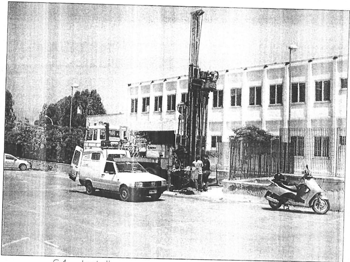
S4 – Installazione piezometri a tubo aperto per
