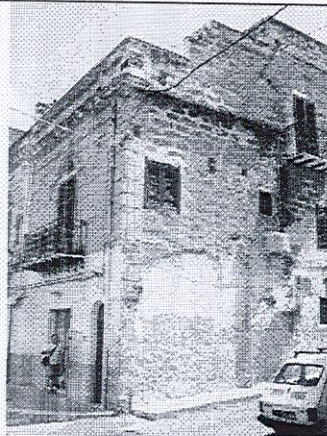
Prospetto su via R. Pilo
