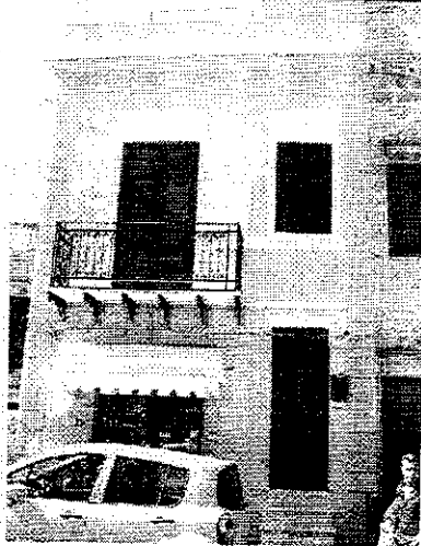
Prospetto su via San Erasmo
