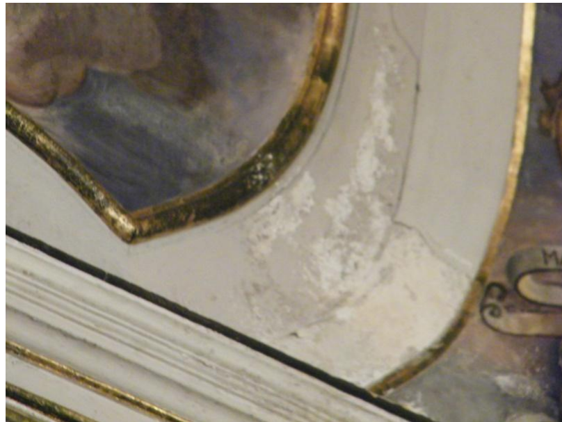
Figura 11 - Fenomeni di decoesione nella volta
