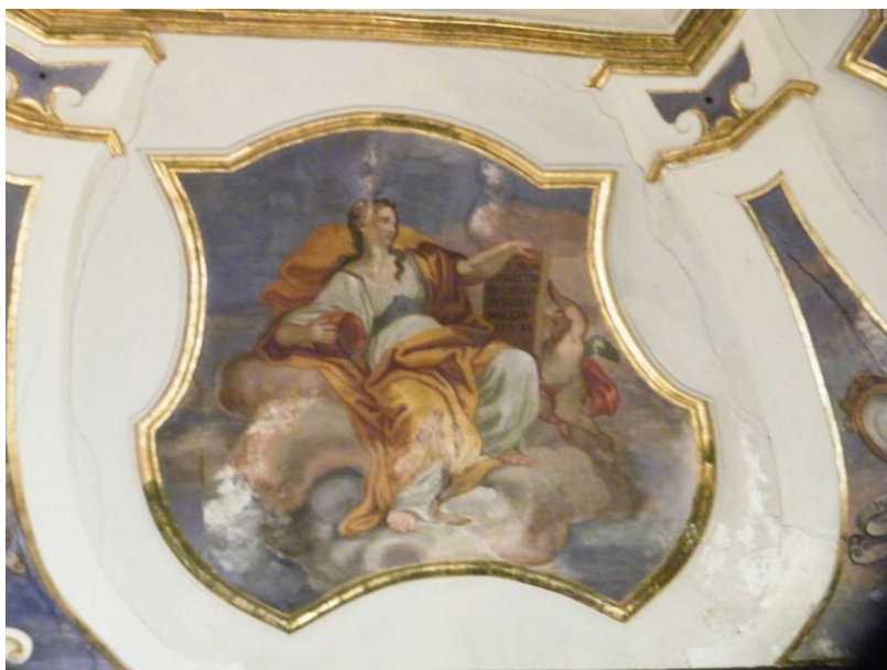
Figura 12 - Alterazione cromatica degli affreschi della volta
