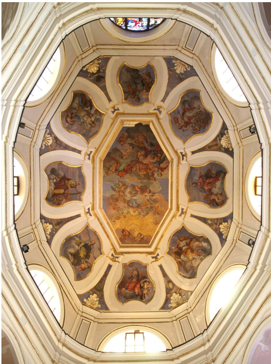
Figura 8 - Vista della volta
