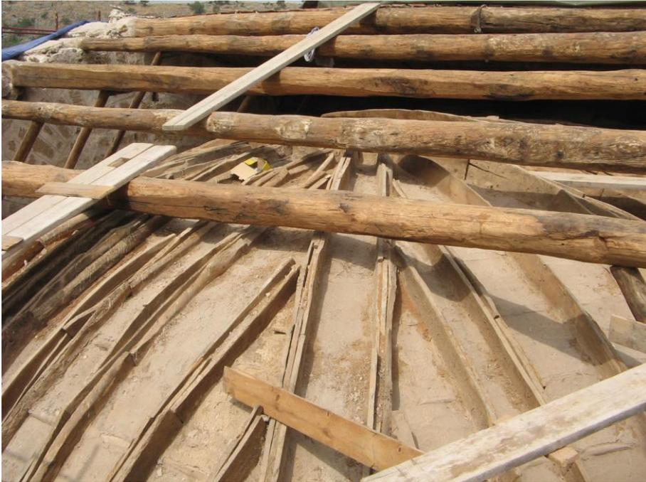
**Figura 7 - Estradosso volta centrale (foto d'archivio)**
